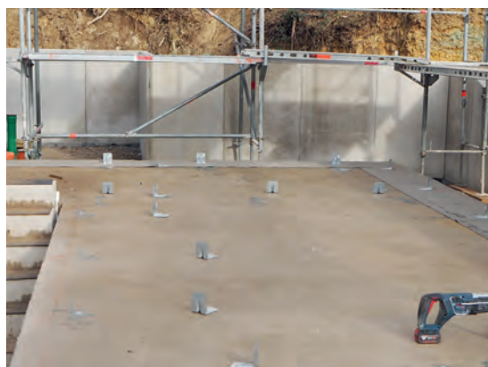
Vorbereitung der Bodenplatte
